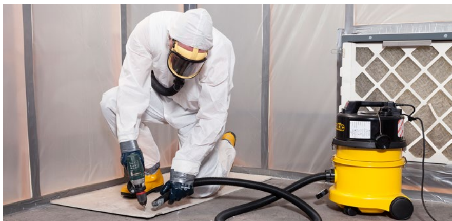
Asbest demonteren met bronafzuiging
