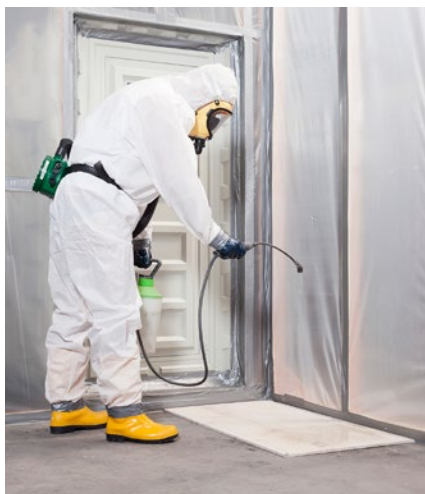
Het te verwijderen asbest vooraf natmaken
